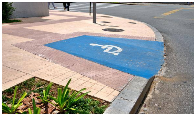
Imagem 6: Exemplo de Calçada com Rampa de Acessibilidade com Piso Tátil
