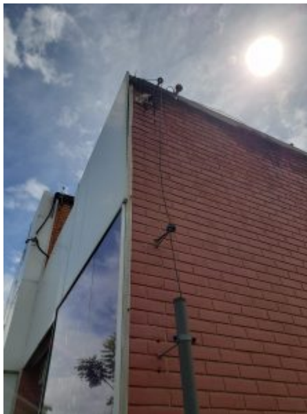
Imagem 46: Descida com Cano de PVC Rígido
