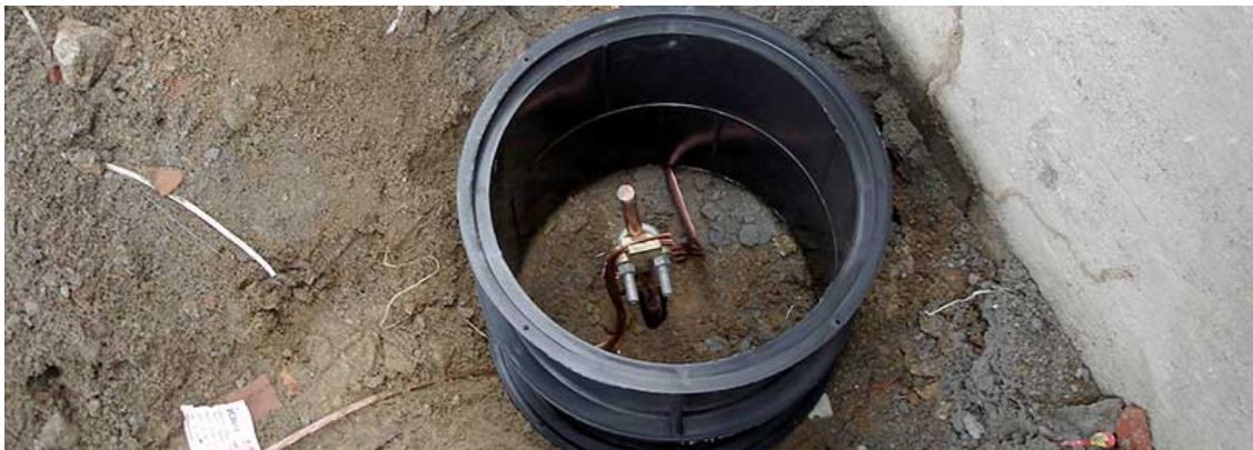
Imagem 47: Caixa de Inspeção com Sistemas de Aterramento
